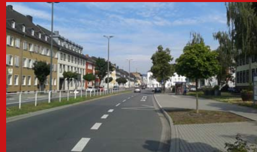
Straßenbeleuchtung Langendorfer Straße Neue Maßnahme
