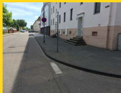
Straßenausbau Rheintalweg Geplant
