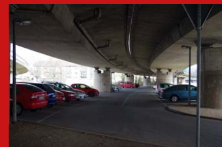
Überprüfung Beleuchtung Parkplatz (an der Germaniastraße) Neue Maßnahme
