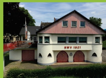
Modernisierung Vereinsheim Abgeschlossen 2010
