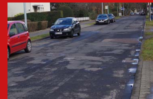
Straßenausbau Germaniastraße Neue Maßnahme
