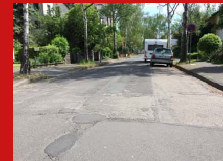
Straßenausbau Elisabethstraße Neue Maßnahme
