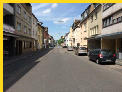
Straßenausbau Engerser Straße Geplant
