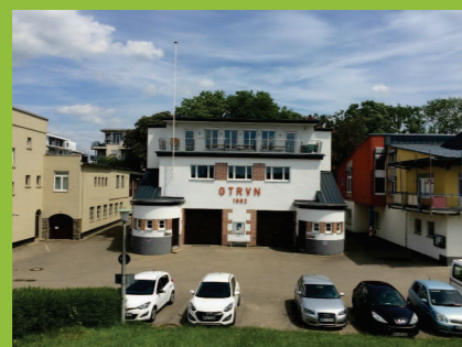
Modernisierung Vereinsheim Abgeschlossen 2013
