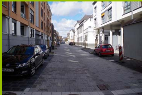
Straßenausbau Rheinstraße Abgeschlossen 2014
