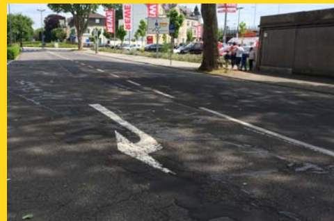
Straßenausbau Wilhelmstraße Geplant
