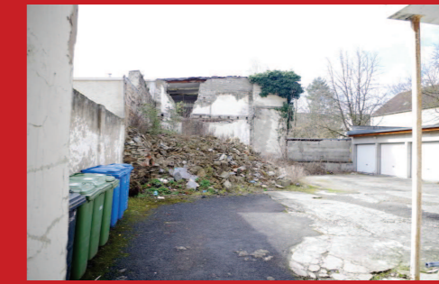
Abbruch von Nebengebäuden Neue Maßnahme
