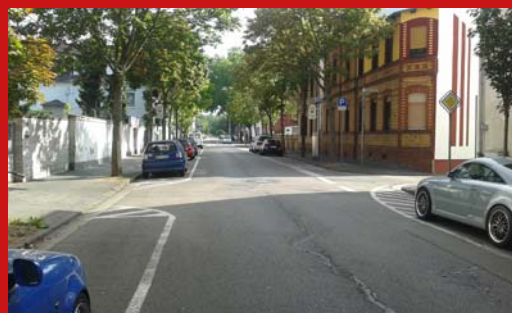
Straßenausbau Wilhelmstraße (2. Teil) Neue Maßnahme
