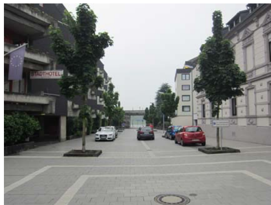
Bild 4: Fahrbahnbelag im Anschluss an die Rheinstraße
