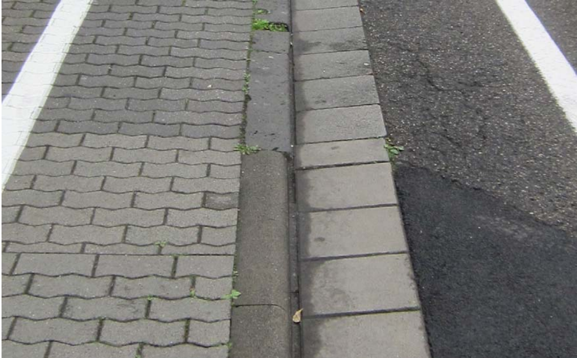
Bild 6: vorh. Randeinfassung / Entwässerung der Rheinstraße
