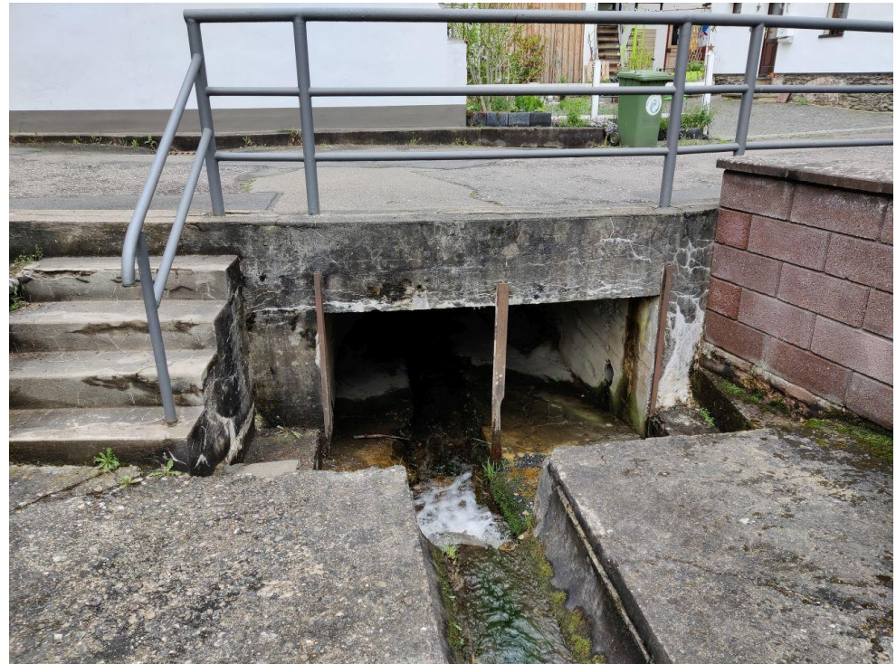
Foto: Unterführung Reichelbach unterhalb der Dorfstraße in Segendorf, Quelle: BCE
