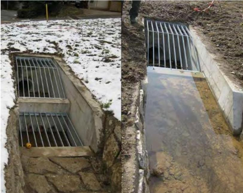
Abbildung 6: Einlaufbauwerk mit Schlamm- und Geröllfang vor und nach Starkregen (Stadt Buchen).
